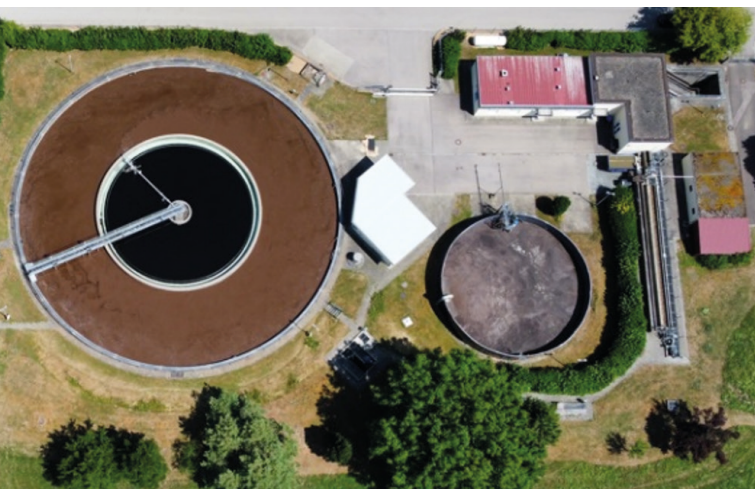
Die Kläranlage in Allmannshofen
